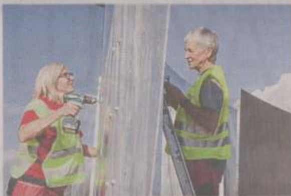
Utrolig mange bolter å skru: Elisabeth Engen, til venstre, og Jorun Kraft Moe deltok i den to uker lange monteringen før den offisielle åpningen 24. september. (Foto: Grethe Britt Fredriksen)
